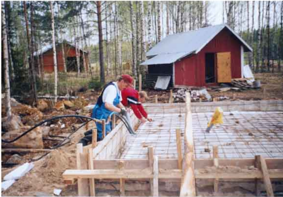
Saunan perustukset työn alla
